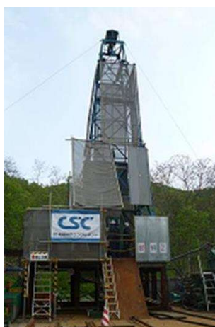
図 2 注入井掘削槽
