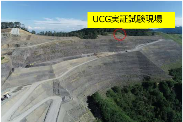
実施現場の状況
