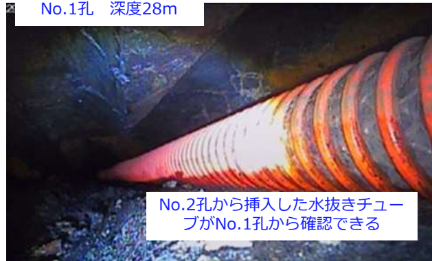
水抜き後の同軸孔と補助生産孔の交差部 水位は30m付近まで後退, 圧縮空気により加圧することで壁面の水滴消失
