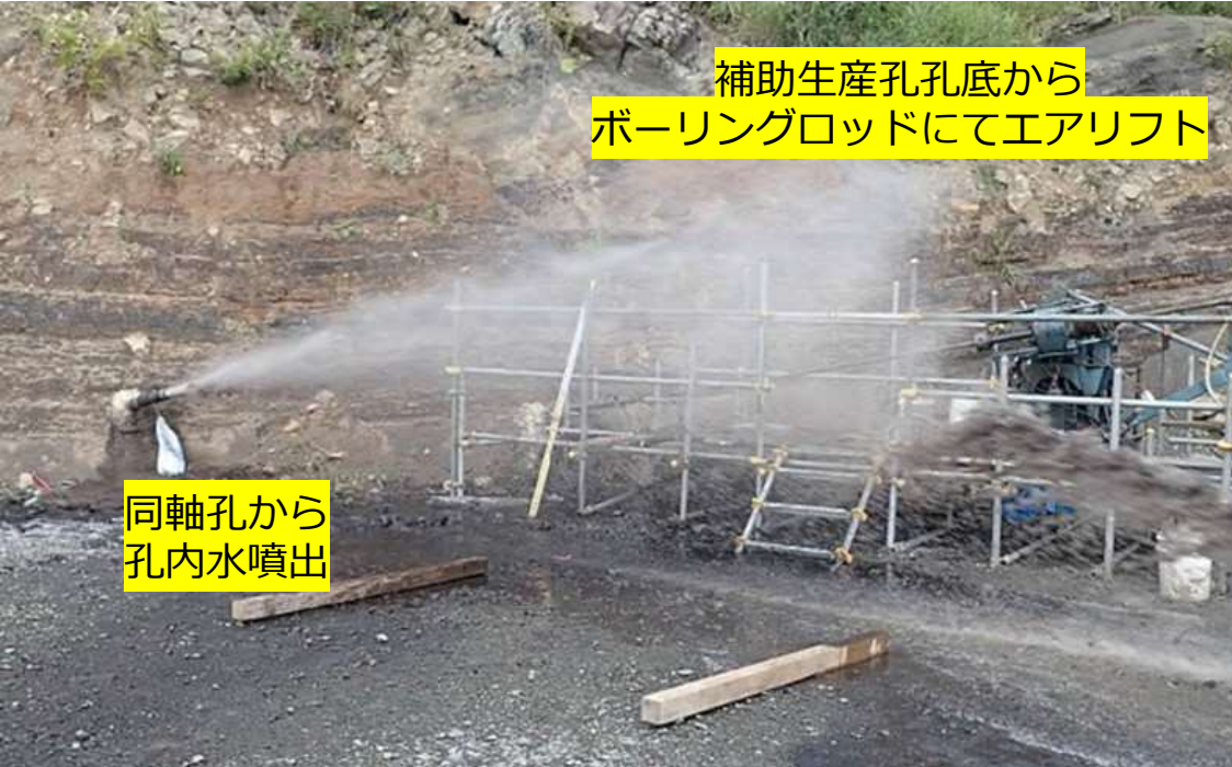
エアリフトによる孔内排水状況 (先端での交差を確認)
