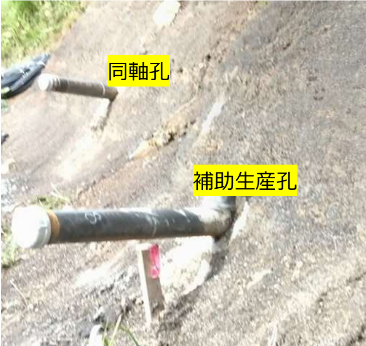
掘削完了後のUCG孔 (同軸孔と補助生産孔)
