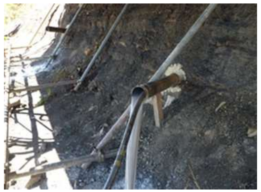
スラリー充填状況
