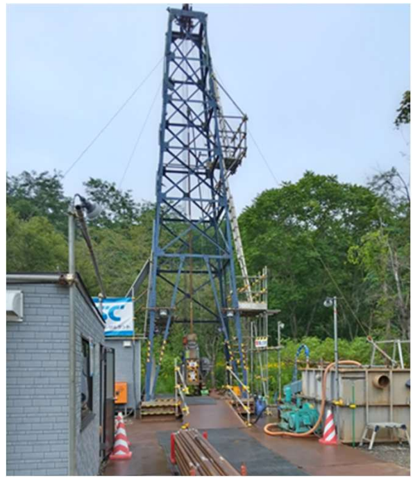
令和6年度の追加掘削工事
