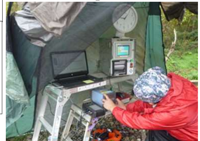
注入圧・流量の計測
