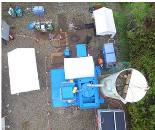
図2 注入試験機器の配置
