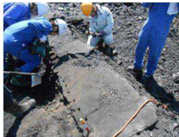
写真 2-2 人力による切出し作業
