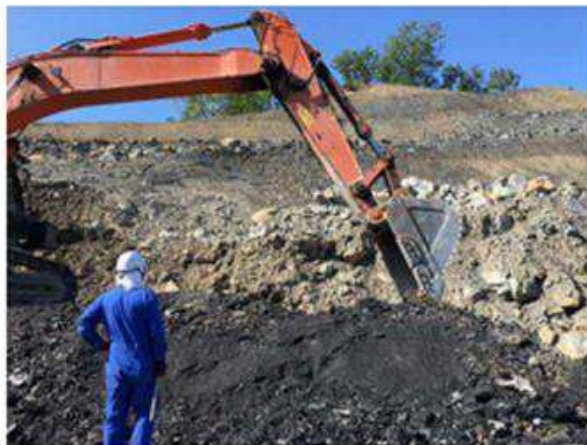
写真 2-1 重機による切削作業
